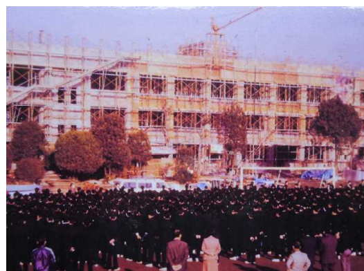
《 現在の校舎建設の様子 》
